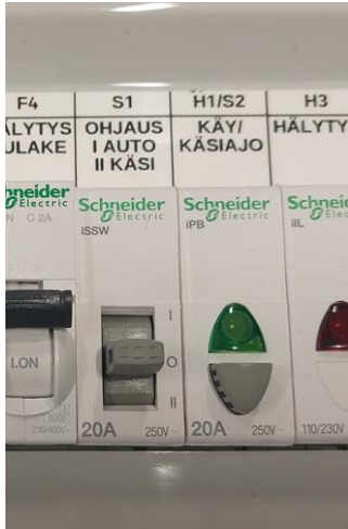
Kuva 6. Ohjauskytkin (S1), käsiajopainike ja vihreä valo (H1/S2)
