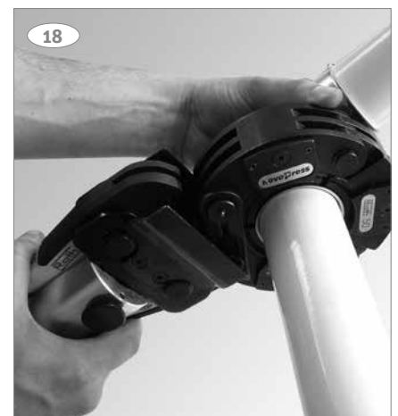
18: Aseta leukapidikkeet puristuskaulukseen, paina käynnistuspainiketta ja irrota laite, kun olet puristanut liittimen.
