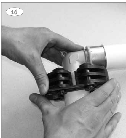
13: 40, 50 ja 63 mm:n puristuksissa käytetään Roth-puristuskauluksia. Avaa puristuskaulus jousitetun pultin avulla.
