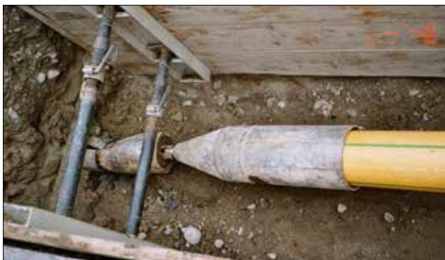
6.25 Vetopää kiinnitetynä suojakuorelliseen putkeen
