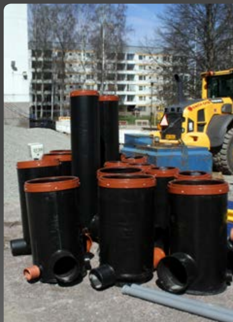
Meltexin rumpuputket ja mittatilauskaivot odottavat työmaalla pääsyä maan alle.
