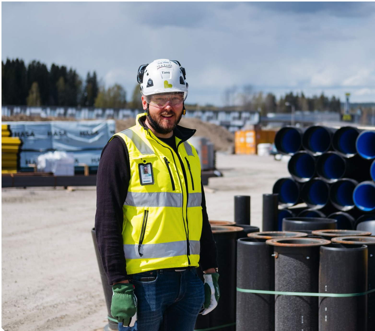
”Tämä on tällä hetkellä suurin Suomessa käynnissä oleva väylähanke”, kertoo vastaava työnjohtaja Timo Takala.
