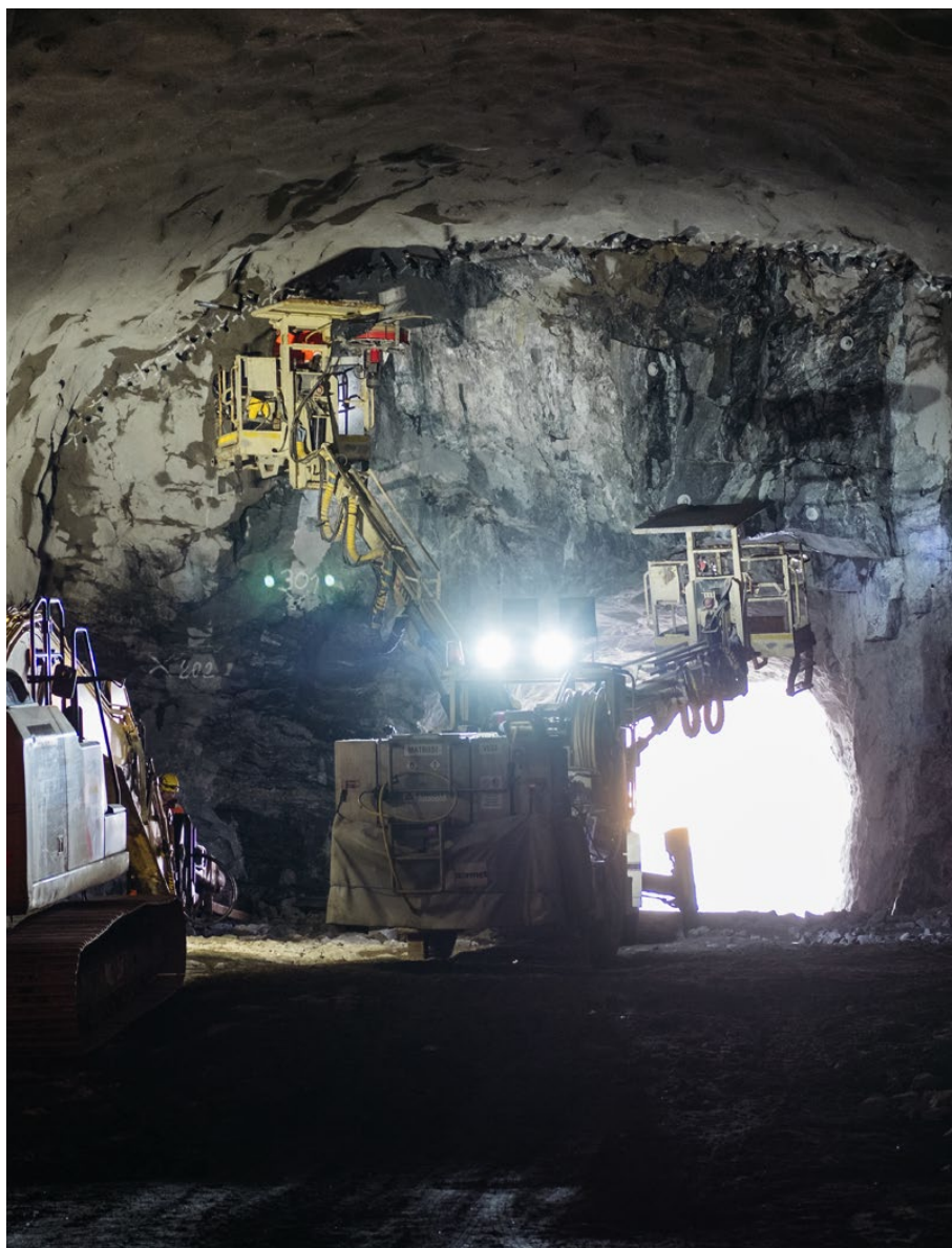
VALTARI-osuudelle rakennetaan muun muassa tunneliteita, pohjavahvistuksia ja tasoliittymiä.
