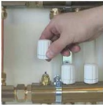
Poista käsisäästöpyörä termostaattiventtiilistä.
