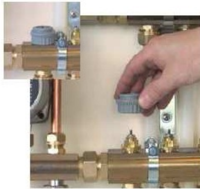
Aseta adapteri termostaattiventtiin.
