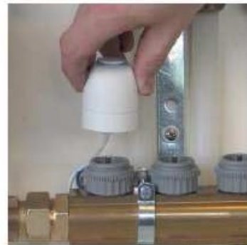
Paina (klikkaa) toimilaitte adapteriin.
